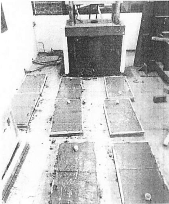
PENGECORAN BENDA UJI PANEL BETON.
