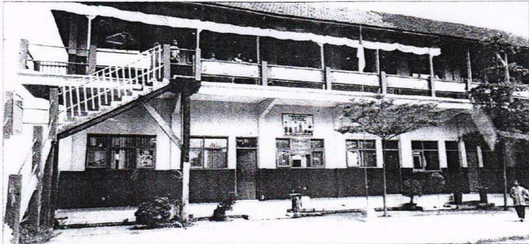
Gambar 8. Gedung sekolah MIS Al-Hikmah Ngampungan
