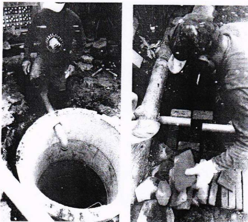
Gambar 9. Pemasangan dan penyetelan pipa penyalur 4"
