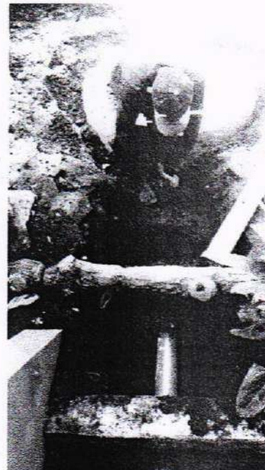
Gambar 7. Pengisian dasar sumur dengan kerikil dan pemasangan pipa penyalur limpasan
