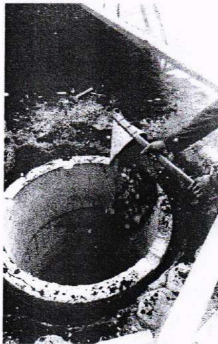
Gambar 7. Pengisian dasar sumur dengan kerikil dan pemasangan pipa penyalur limpasan
