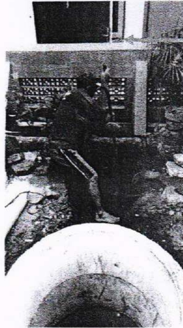
Gambar 6. Pengecekan Kedalaman sumur
